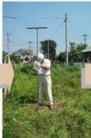
② SS調査後の残孔にサンプラーを挿し込む。
