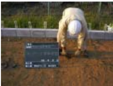
《土質採取状況（試験地）》
